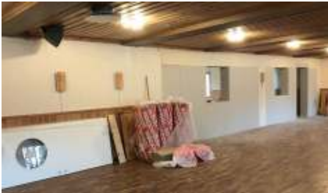
Byggnationerna i full gång.
